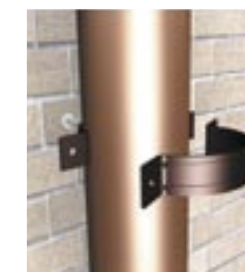
Obejmy skręcamy ze sobą wkrętami tak aby rura nie mogła się wysunąć.
